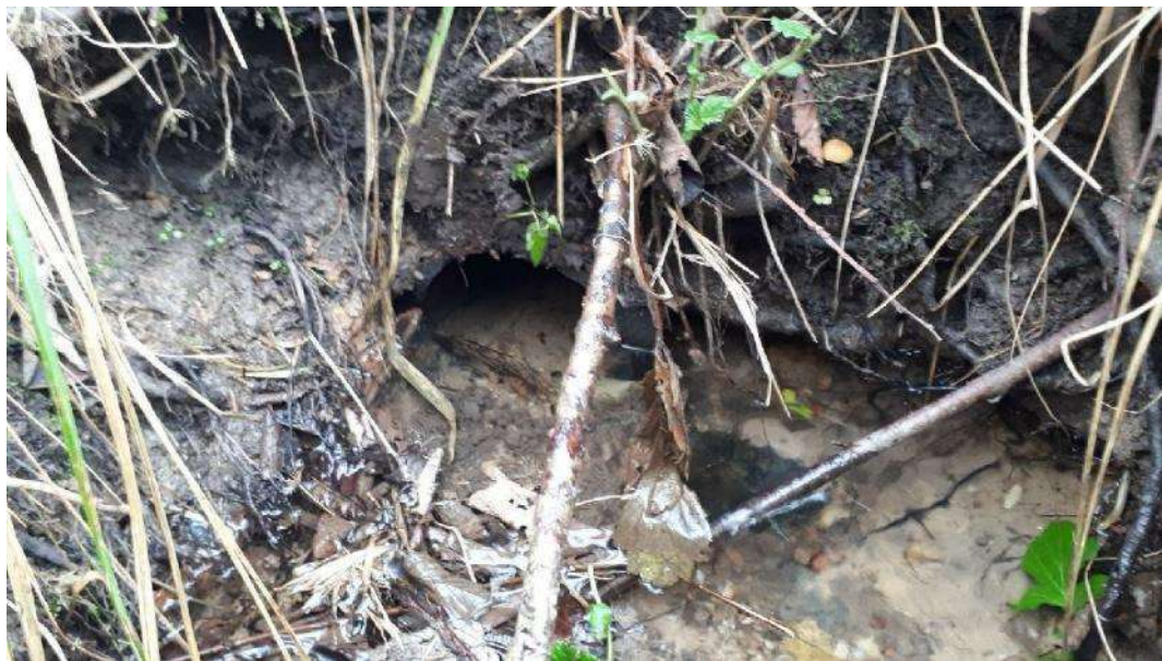
Foto 4. Drenaažisüsteemi nr 7 suue (Ø150 toru ots). Torus 1/3 liivast setet.
