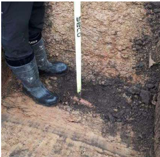
Foto 6. Kaeve 1. Drenaažisüsteemi 7 kollektor.
